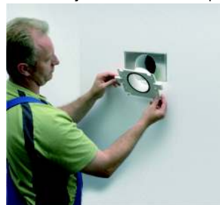
Slika 8 vgradnja držala dovodnega elementa
