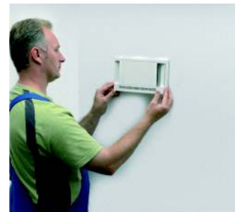
Slika 10 vgradnja dovodnega elementa
