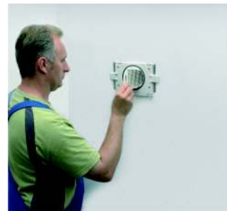
Slika 9 vgradnja filtra proti insektom
