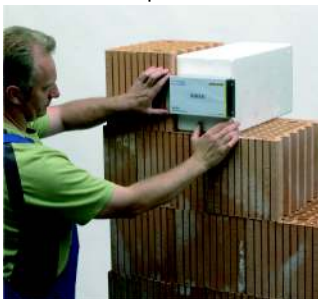
Slika 7 vgradni blok v grobi gradnji
