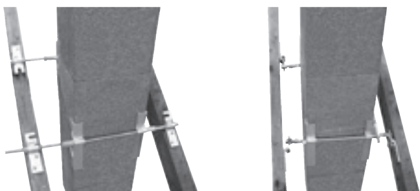
Držalo dimnika – pritrditvev na špirovce
